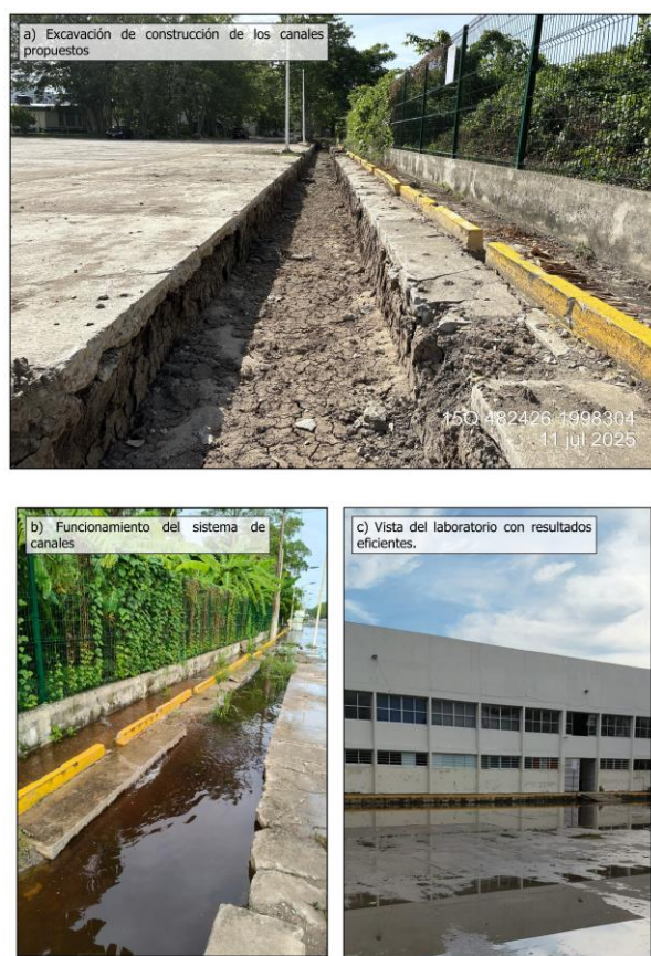
Figura 12. a) Ampliación de área hidráulica en canales, b) funcionamiento del sistema de canales y c) Vista del laboratorio con resultados eficientes.
