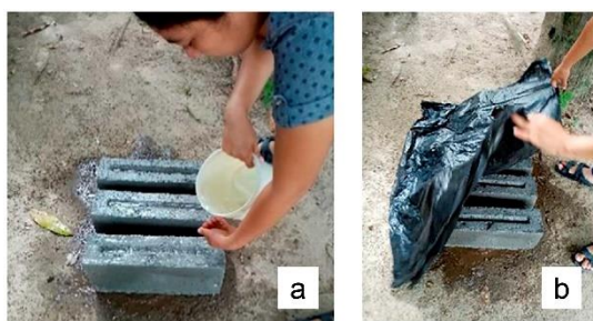
Figura 6. Curado artesanal: (a) humedecimiento, (b) cubierta para evitar evaporación de agua.
